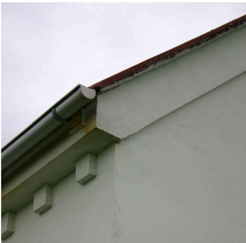
Mynd 22. Vindskeið, þakskegg og tannstafur á Flateyjarkirkju 74
